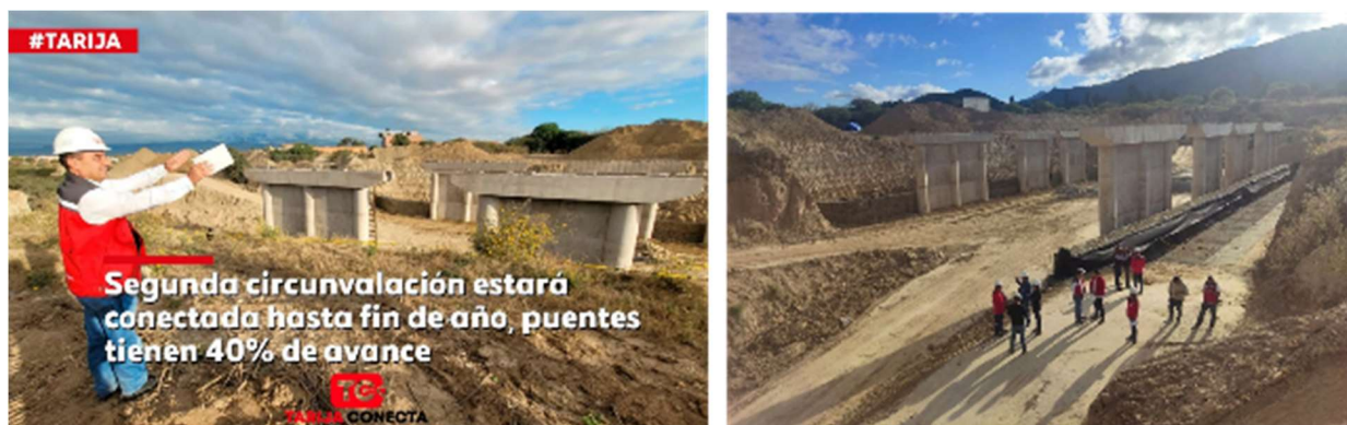
Figura 1. Proyecto en ejecución Segunda Circunvalación. Tarija - Bolivia
