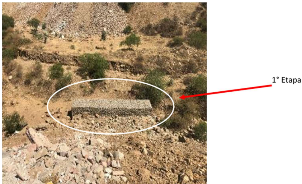
Figura 5. Construcción de gavión
