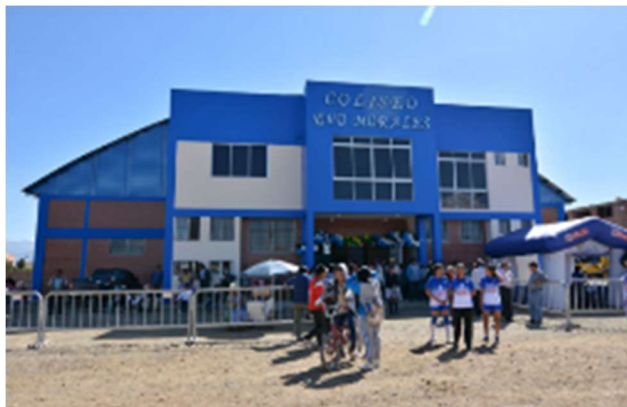
Figura 21. Construcción de coliseo
