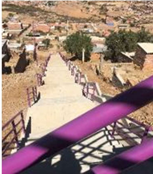
Figura 17. Construcción de escalinatas
