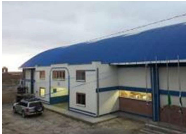
Figura 20. Construcción de coliseo
