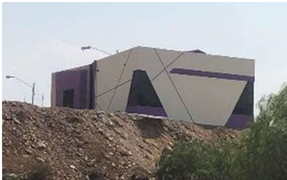
Figura 9. Proyecto Construcción Centro Cultural
