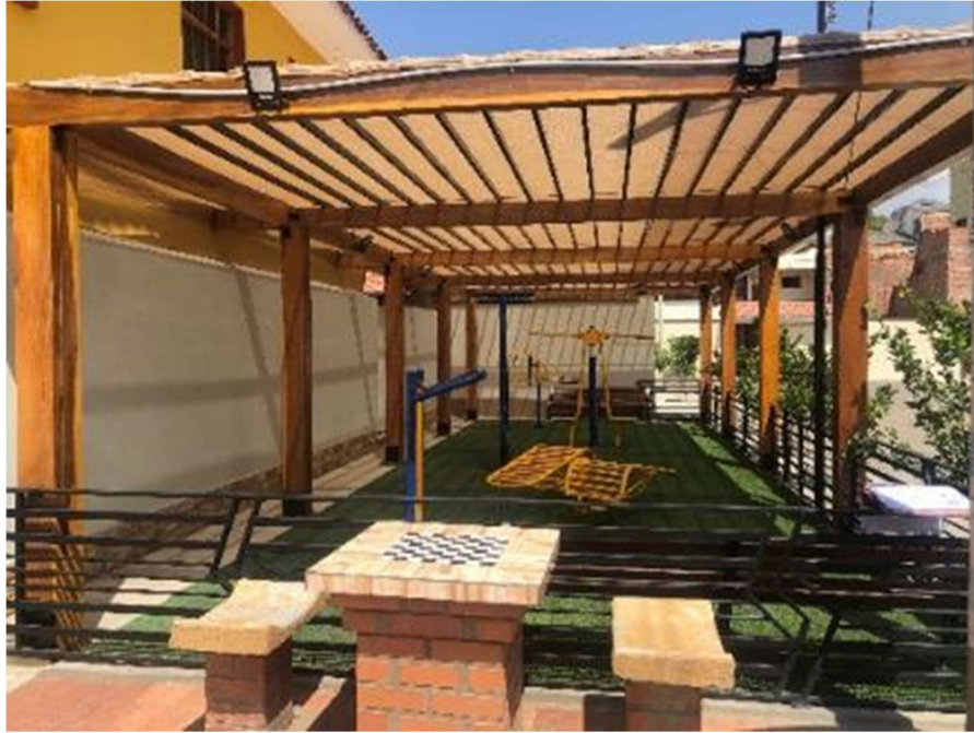
Figura 2. Proyecto Construcción Cubierta para Gimnasio, C/Fco. Gonzales y G. Tartini, OTB La Promotora. Distrito 3 (Zona norte del municipio).
