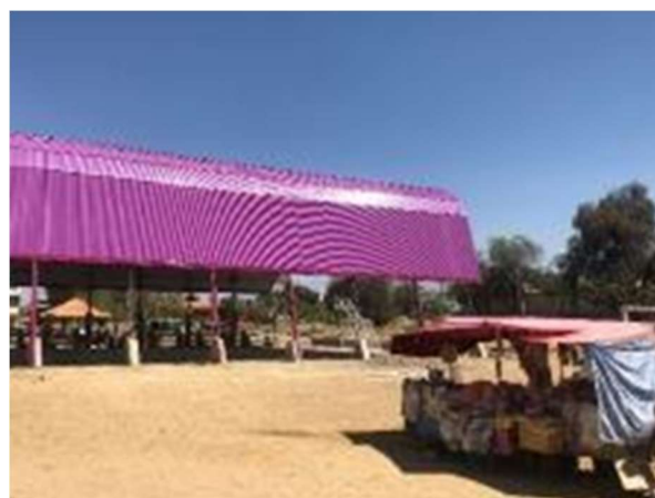
Figura 16. Construcción de tinglado
