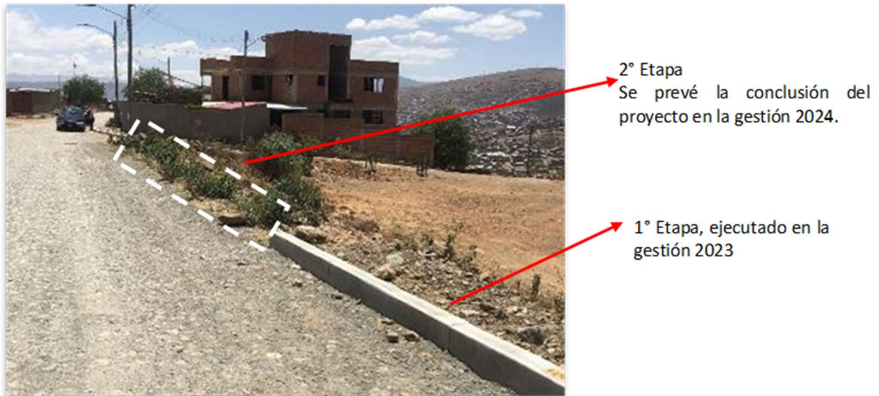
Figura 6. Proyecto: Construcción Cunetas y Cordones sobre Vías. Mzo 166, 167, 168, 169, 170 y 171, OTB Chaupiloma Central. Distrito 15.
