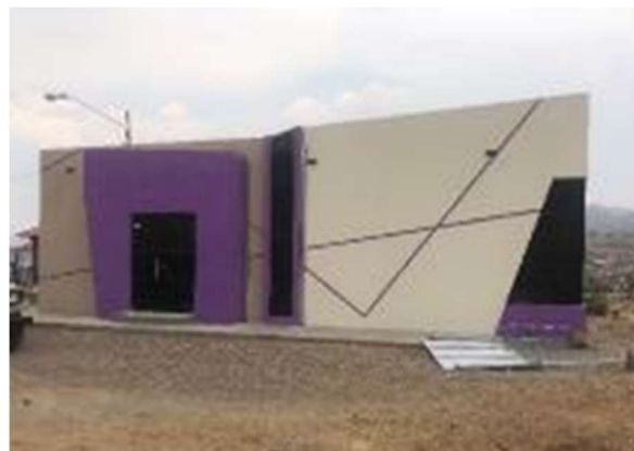
Figura 18. Construcción centro cultural
